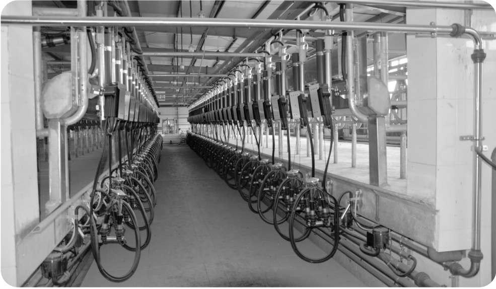
由北京首农集团和洮北区牧业发展区中牧公司合作，投资10亿元的2.5万头奶牛养殖项目，目前牛舍、牛床等拆除施工基本结束，首农集团8人技术团队正在对牛舍进行规划设计。8月份首期5000头奶牛将入驻养殖基地。图为技术人员正在调试设备。 李岩峰摄
