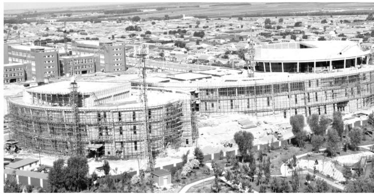
文化产业创意园项目是辽南市委、市政府的一项重点工程,也是提高市民幸福指数的惠民工程。建成后将成为辽南市内的标志性建筑,大大提升城市品位,增加城市亮点,提高城市内涵。项目总投资9000万元,占地18496平方米,建设面积24993平方米,其中包括新建影剧院、文化馆、博物馆、公共图书馆、电影院、艺术团、游泳馆、蓝排球馆等场所,现在已经完成南、北区桩基础和主体结构封顶,正在进行网架结构组装和剧院砼结构封顶,预计9月末全部竣工。
