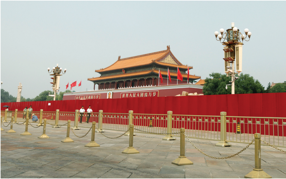
这是天安门城楼南侧为修建临时观礼台而搭建的护栏（8月11日摄）。目前，北京天安门区域用于“9·3”阅兵的临时观礼台、大屏幕等设施正在紧锣密鼓搭建中。
