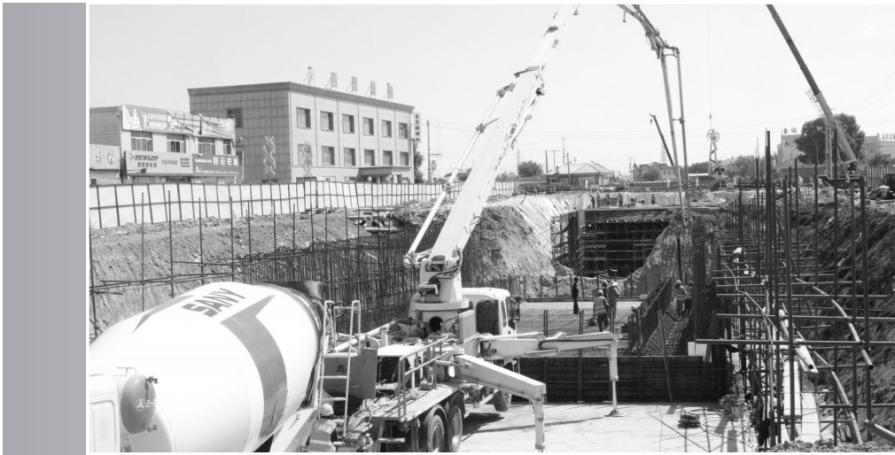
洮南市南道口公铁立交项目于今年4月份启动,将于今年10月完工。该项目主要由下穿和两侧道路部分组成,全长360米,全路段均为直线段,预计总投资2566.8万元。该项目建成后将有效减少交通事故的发生,促进区域经济的发展。图为日前建设中的公铁立交项目。本报记者张殿文摄
