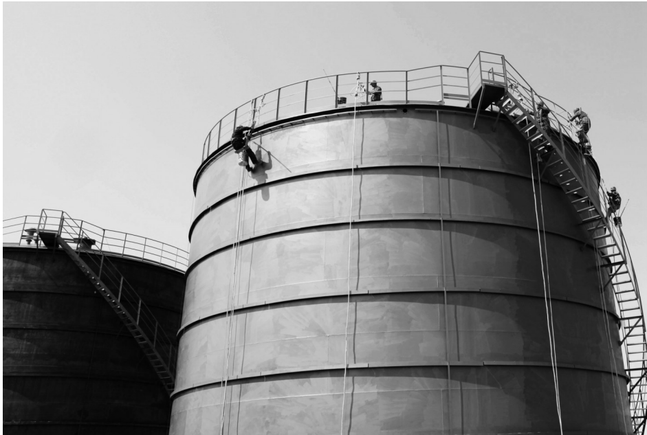
▲大安加快经济转型升级，全市3000万元以上重点项目开复工39个，生产经营型项目数量近三分之二，增强了发展后劲。图为煤焦油轻质化项目建设现场。
