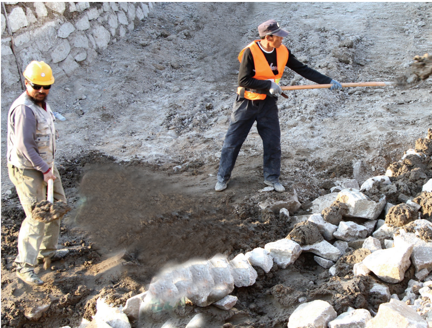
图为工人在市区新华广场附近挖蓄水池。
