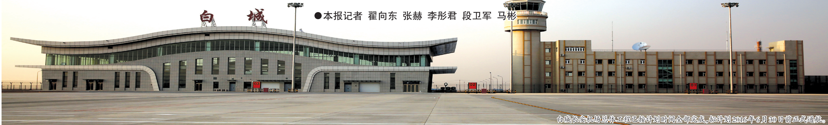
白城长安机场主体工程已按计划时间全部完成,按计划2016年6月30日前正式通航。
