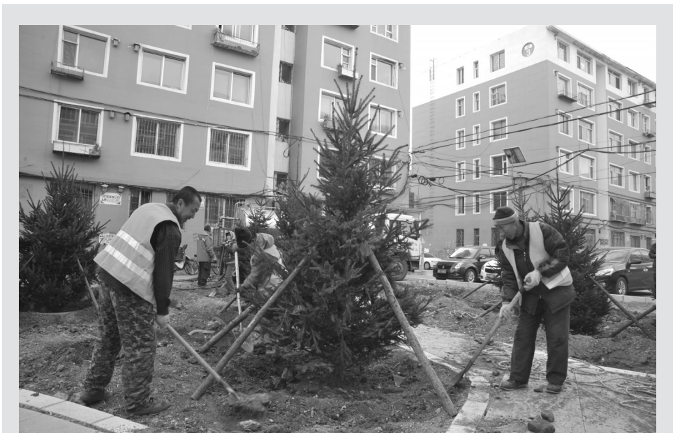
洮北区按照海绵城市建设工程要求,克服老旧小区空间条件有限、改造难度大等问题,抢进度、保质量,加快推进小区改造建设。近日,他们对百福小区、检察院小区、北丰小区、白鹤五小区、西白鹤小区、东白鹤小区内的传统绿化带及花坛进行重新设计改造,铺设嵌草砖等透水性材料,并在新建小区雨水花园内增植适合北方生长、蓄水性强的树木。今年冬季,洮北区计划在改造小区内种植云杉144棵、垂柳120棵、山杏386棵,栽种任务预计11月完成。图为11月4日,施工人员正在北丰小区种植云杉。
