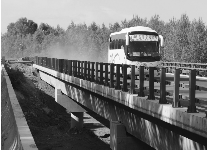
洮北辖区县级公路镇农线上，新建半拉山大桥正式建成通车。该桥长307米，宽12.5米，总投资2400万元。半拉山大桥位于洮南北部与白城市查干浩特旅游经济开发区交界处，是洮北区、内蒙古兴安盟通往洮南北部乡镇的重要通道。新桥的建成使用，不仅彻底解决了旧桥的安全隐患，对周边经济发展也将起到积极的推动作用。 王绍利摄
