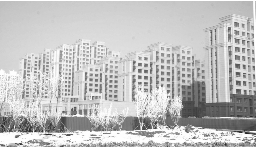
2015年以来，洮北区委、区政府牢固树立“抓民生就是抓发展”的施政理念，全面推进以民生为重点的社会建设，加快推进棚户区改造工程建设，真正做到发展为民、发展利民，让全区人民共享发展成果。图为已建成的棚改回迁楼群。 李岩峰摄
