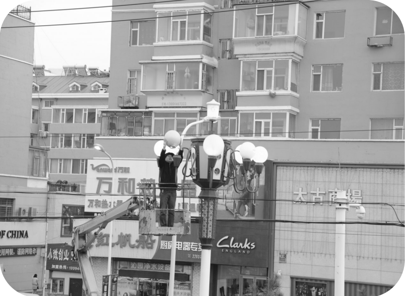
北方冬季日短夜长，为了保证市区路灯亮灯率，方便市民夜间出行，洮北区全面实施辖区老旧路灯灯泡更换工作，路灯维修人员日夜巡查街道两侧的照明设施，修旧换新，擦亮了城市的“眼睛”。图为路灯维修人员在城市主干道旁更换故障灯泡。 孙文涛摄
