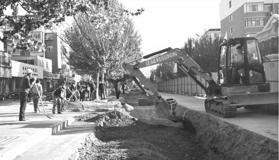
白城市海绵城市建设工程实施以来，洮北区严格按照海绵城市建设工程要求，对市区文化路、新兴路、民主路、金辉路、青年街、爱国街等多条街路，以及白鹤小区、百福小区、检察院小区、北市小区进行改造。2015年共完成4大类44项基础设施工程。图为雨污水管网改造工程施工现场。 王维俊摄
