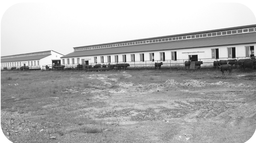
全县大规模化养殖小区——通榆县维多利草原红牛养殖基地,建有840平方米堆肥场,畜禽粪便综合利用率达到100%。
