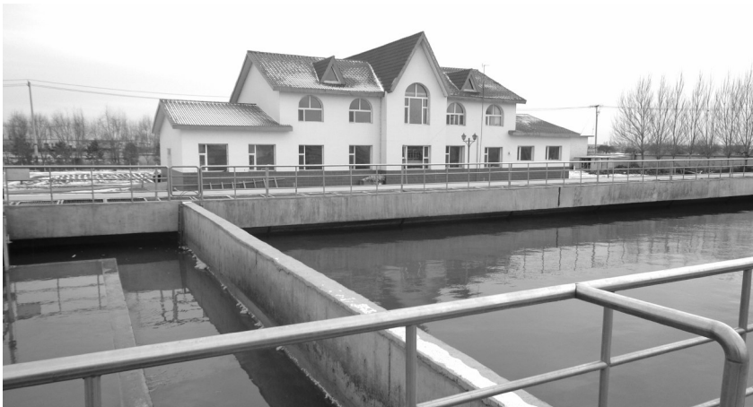
通榆县污水处理厂,占地面积5万平方米,投入使用后日处理污水能力将达到3万吨,处理标准达到一级A。
