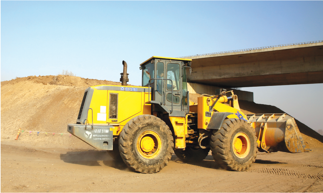
3月27日,在洮北区德顺蒙古族乡境内的嫩升高速公路施工现场,机械轰鸣。我市境内嫩升高速公路项目收尾工程即将全面展开。 本报记者李晓明摄
