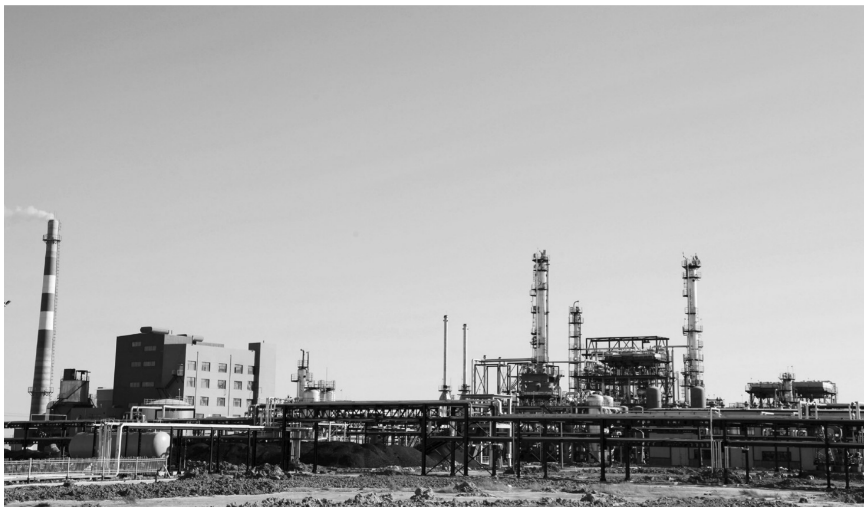
一期投资5亿元的煤焦油轻质化项目实现机械联动试车。
