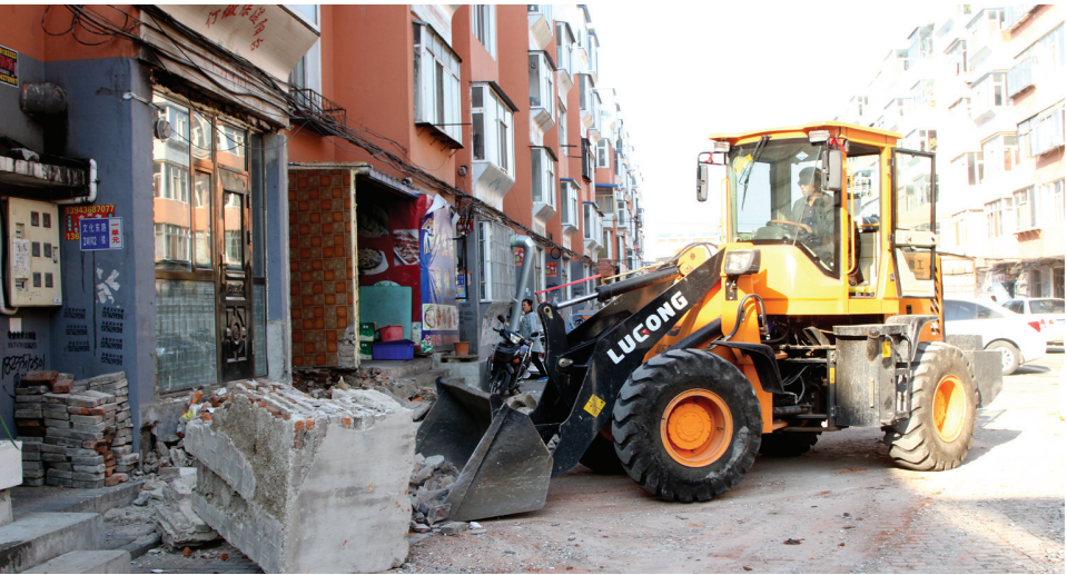
洮北区白鹤一号街坊小区居民积极拆除违建。本报记者张殿文摄
