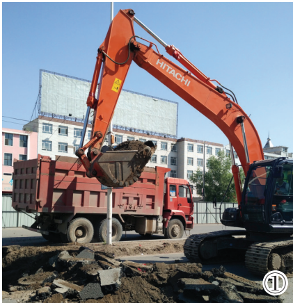
图为市区新华路施工现场。
