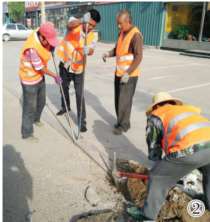
图为白城经开区保胜路施工现场。本报记者李晓明摄
