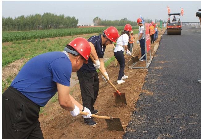
白城市交通局党委组织全体党员到嫩丹高速公路白城至黑水标段现场，和修筑公路的工人一起劳动，体验筑路工人的辛苦，净化心灵，向党的95岁生日献礼。
