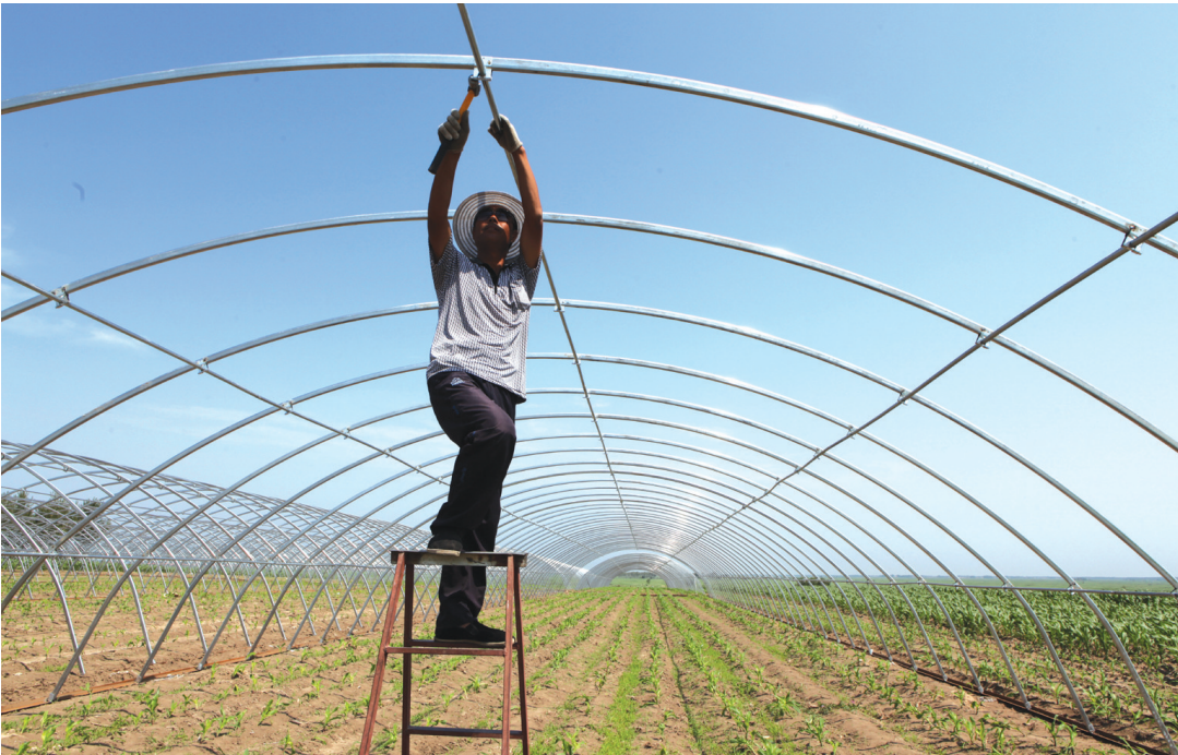
镇赉县落实国家产业扶贫政策，把扶贫资金用在“刀刃”上。该县嘎什根乡投入扶贫资金100万元，给贫困村——立新村建设稻田育秧、蔬菜生产大棚，改善稻田育秧条件，助其发展蔬菜种植产业。图为嘎什根乡立新村扶贫大棚安装现场。
