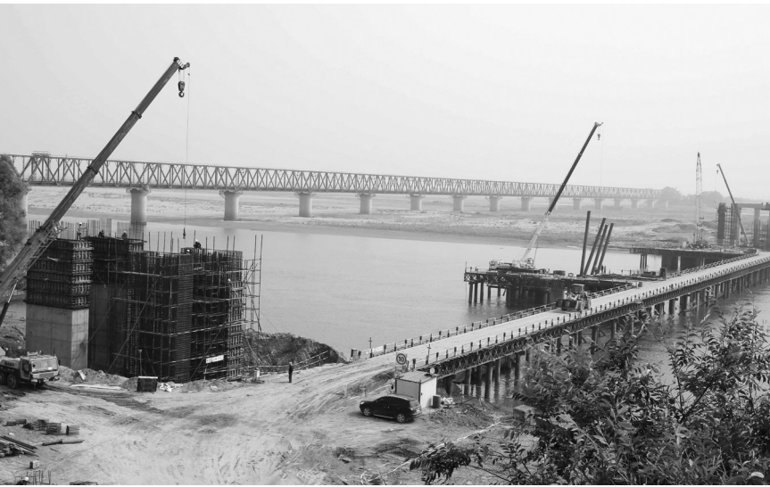
大安市以项目建设统领全局工作，实施3000万元以上项目77个，其中亿元以上项目26个，10亿元以上项目2个，完成投资36.53亿元，增长14%。图为正在建设中的嫩江公路大桥。
