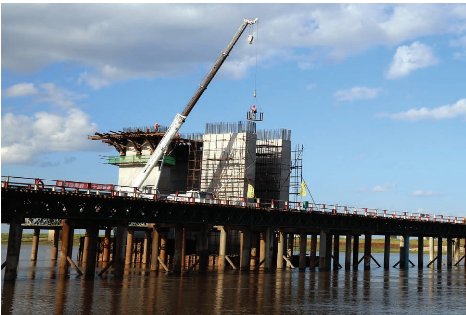
中秋期间,大安市呈现一派热火朝天的建设景象,施工人员放弃休息奋战在项目建设一线。图为正在建设中的嫩江公路大桥。 姜伟明摄
