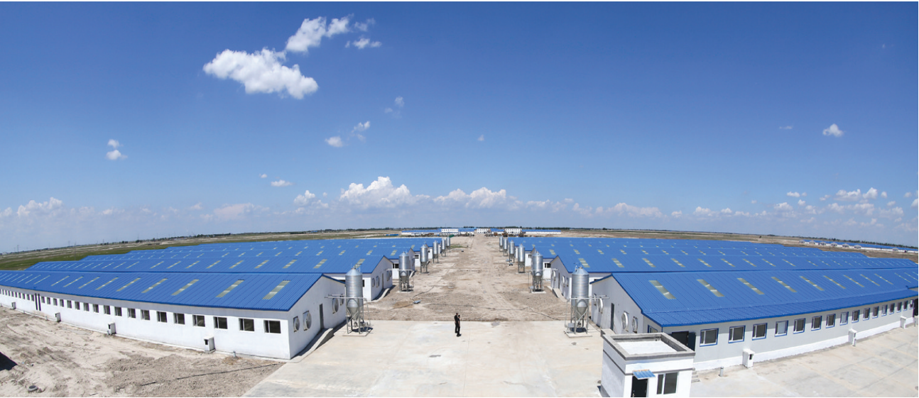
雏鹰农牧集团股份有限公司是一家大型畜禽养殖加工企业,该企业积极响应辽南市委、市政府骨干龙头企业带动农户脱贫的号召,创建精准扶贫养殖区65个,帮助全市65个贫困户、780户贫困户、1560口人实现脱贫致富。图为雏鹰农牧集团股份有限公司养殖区。
