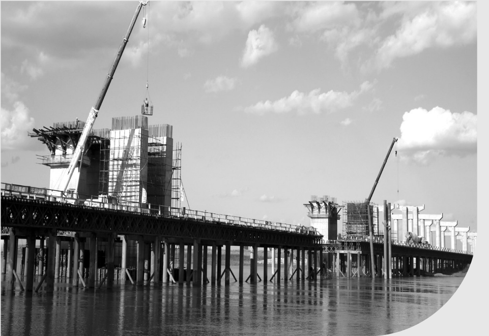
长白快铁、嫩江大桥等重点工程有序推进,K208公铁立交桥建成通车,新建和改造城市街路38条、农村公路1338公里,大安城乡基础设施更加完善。图为建设中的嫩江公路大桥。
