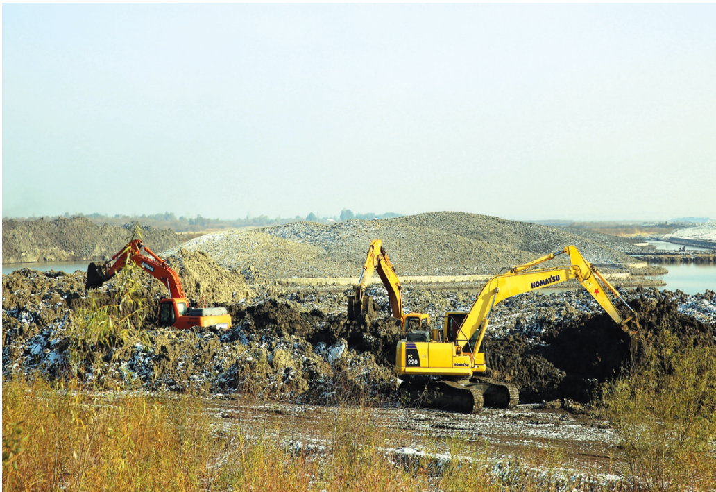
深秋时节,大安市嫩江湾外滩治沙工程施工现场仍然机声轰鸣,挖掘机正在紧张作业。这一工程将嫩江湾现有农渠、水系进行梳理整合,对原有河道进行清淤疏浚,扩建调蓄湖多层次蓄水保水,以水促进生态恢复。
