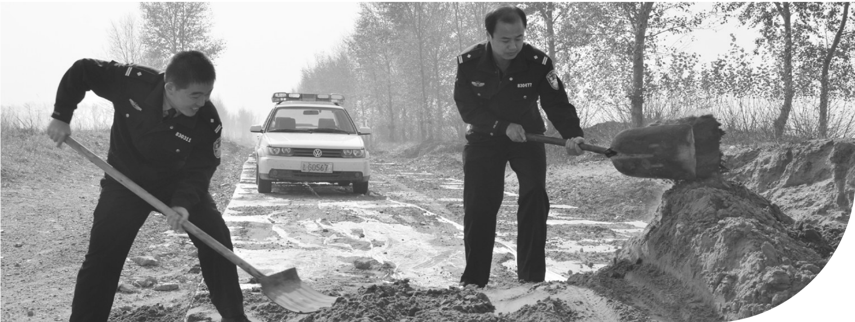
民警及时排除道路安全隐患,将道路上妨碍车辆正常通行的积土清除,保证道路安全畅通
