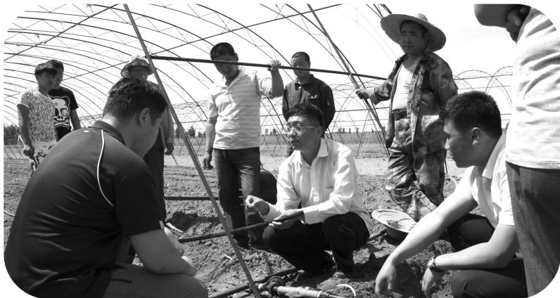
省工信厅联合吉林喜丰节水科技股份有限公司投资80万元,为建平乡大岗村修建了46400平方米的蔬菜大棚(一期工程),覆盖116个贫困户。同时,吉林喜丰公司又把把新型节水灌溉项目落户大岗村的扶贫大棚。有了水源的保障,贫困户可以在大棚里种植反季节蔬菜。图为省工信厅技术人员在大岗村指导村民安装灌溉设施
