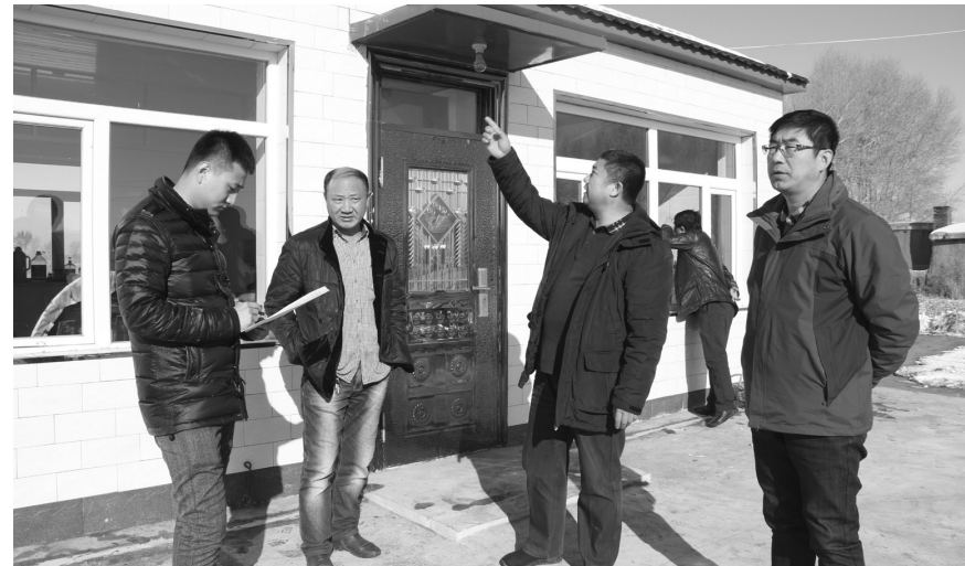
省住建厅驻村干部踏查村民新居的吊棚进度
