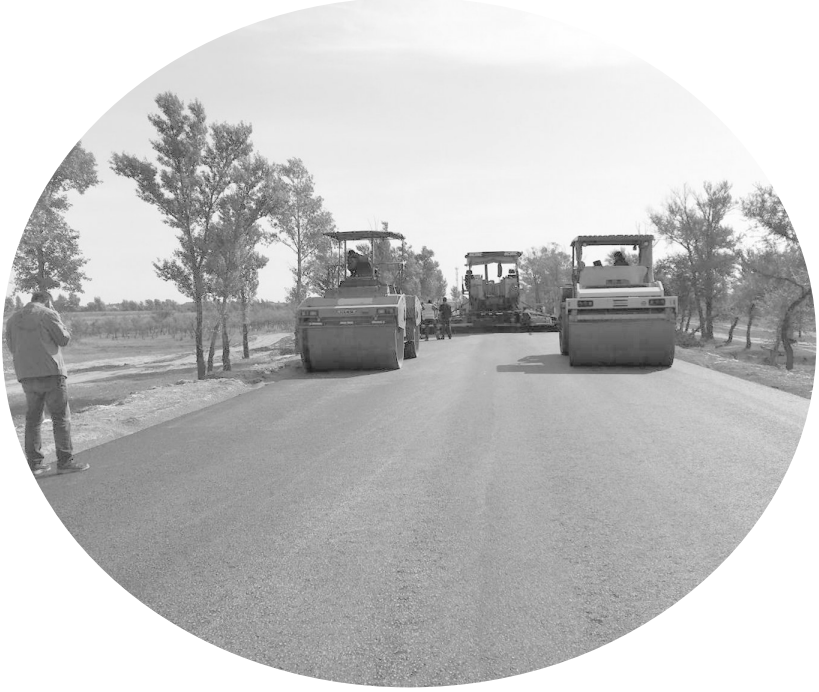
省道S519通榆至向海公路通榆至高罕营子段项目路面铺设
