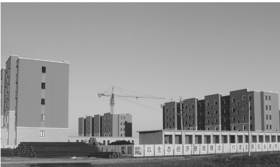
乌兰花镇陆家村易地搬迁小区实景
