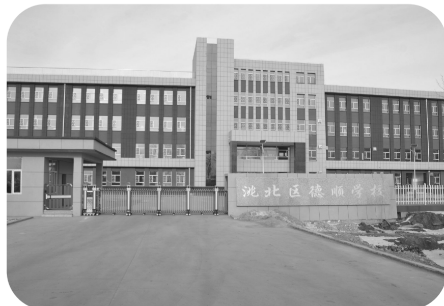
新建并投入使用的德顺学校教学楼
