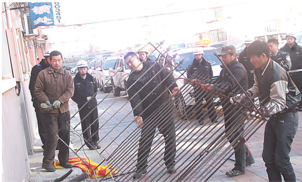
由中国邮政储蓄银行白城市分行包保的金辉小区目前有14处违建,经过多次走访、协调,包保单位终于和业主达成共识,于3月16日成功将该小区4处违建拆除。图为工作人员正在拆除违建铁栅栏。本报记者张殿文摄
