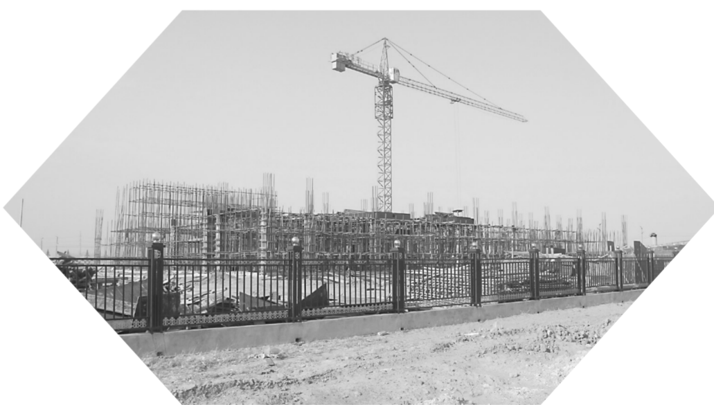
通榆县“六馆一中心”项目施工现场。
