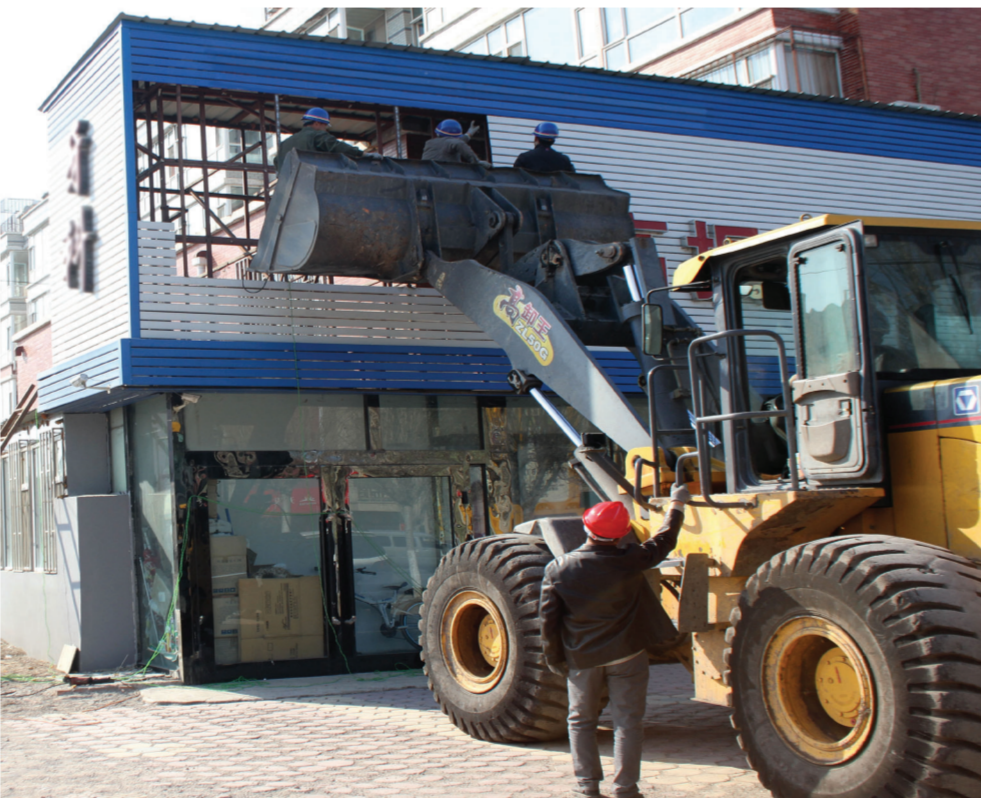
3月16日,工作人员在市区胜利街A区有序拆除违建建筑。自全市老城改造拆违工作开展以来,白城市委办高度重视,认真研究部署,耐心细致做好相关工作,截至目前,已拆除违建建筑面积2037平方米。本报记者王野村 刘冠男 摄
