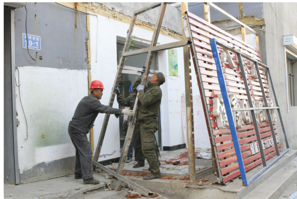
今年,白城市机构编制委员会办公室市承接了市区海明西路19-1号楼6户违建拆除任务。为了尽快拆除违建,办领导多次带领工作人员与业主耐心沟通,并于3月16日成功拆除违建。图为工人正在拆除违建。 本报记者马彬摄
