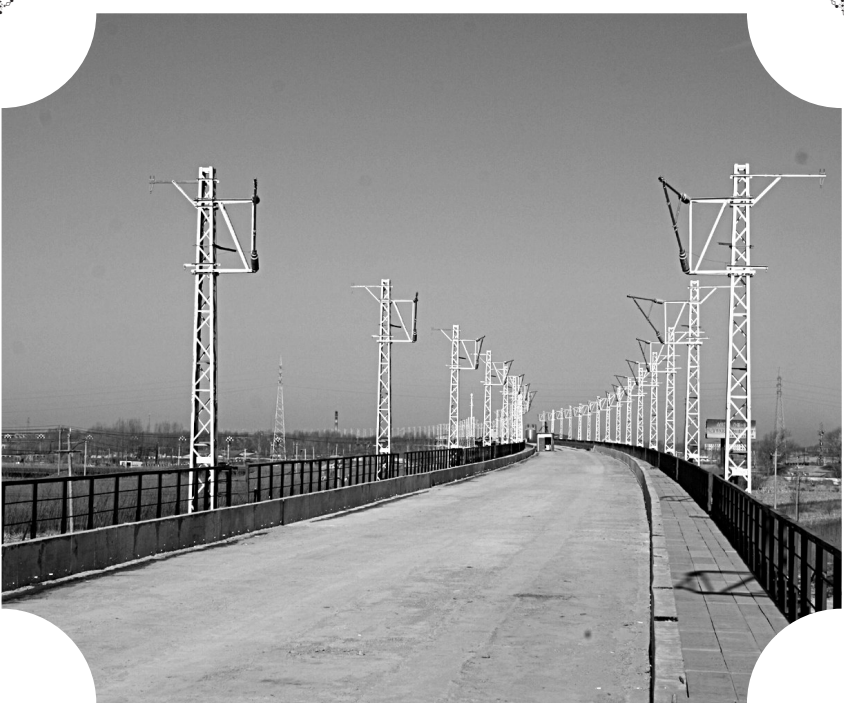
长白铁路扩能改造工程平稳推进。
