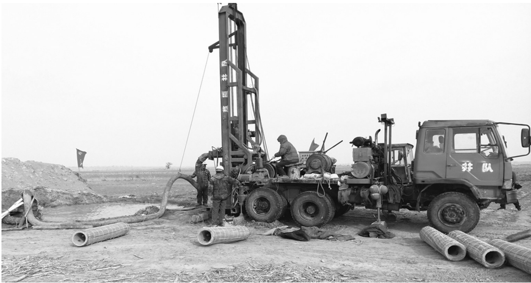
备春耕时节，通榆县苏公坨乡农田里，县草原井队正在为膜下滴灌项目工程打水源井。苏公坨乡通过近几年膜下滴灌项目的实施，形成了规模效益，提高了耕地利用率，增加了农民收入，激发了农民发展农业生产的积极性，有效改善了生态环境和农业生产条件。
