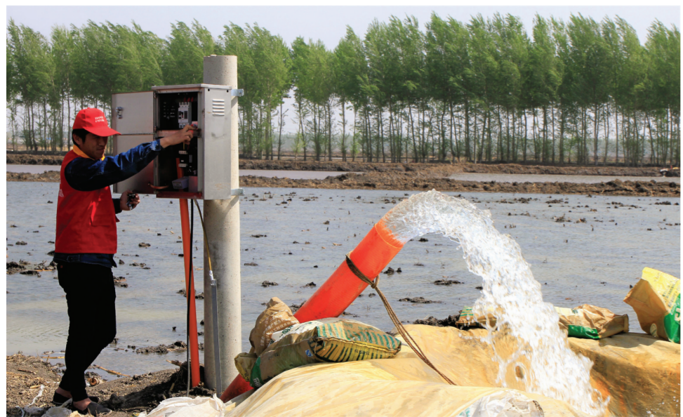
洮北区德顺蒙古族乡白吉村在投资300万元完成“井井通电”工程基础上,自筹资金150万元,铺设低压电缆2.73公里,安装低压控制箱115套,提前一年实现115户机井通电,保证春耕抗旱灌溉的需要,这在我市尚属首例。 本报记者马彬摄
