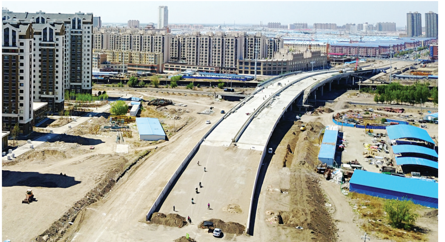
一桥连南北 即将变通途。目前,备受广大市民关注的长庆公铁立交大桥建设工程正在紧锣密鼓施工之中。记者在现场看到,施工现场机械轰鸣,工人干劲十足,他们铆着一股劲,力争让这座连接新老城区的纽带桥早日竣工通车。 本报记者李晓明摄
