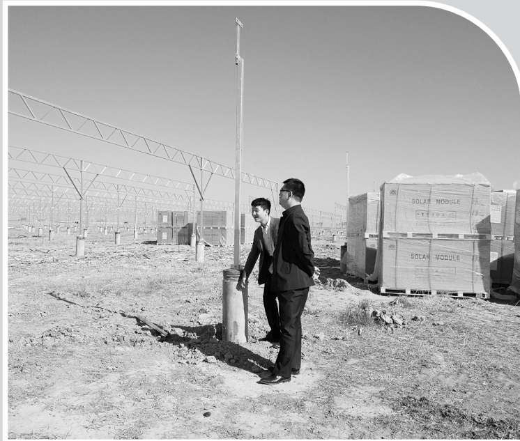
大安市民政局扶贫工作队到烧锅镇新平村光伏发电项目现场查看建设情况。 于森摄
