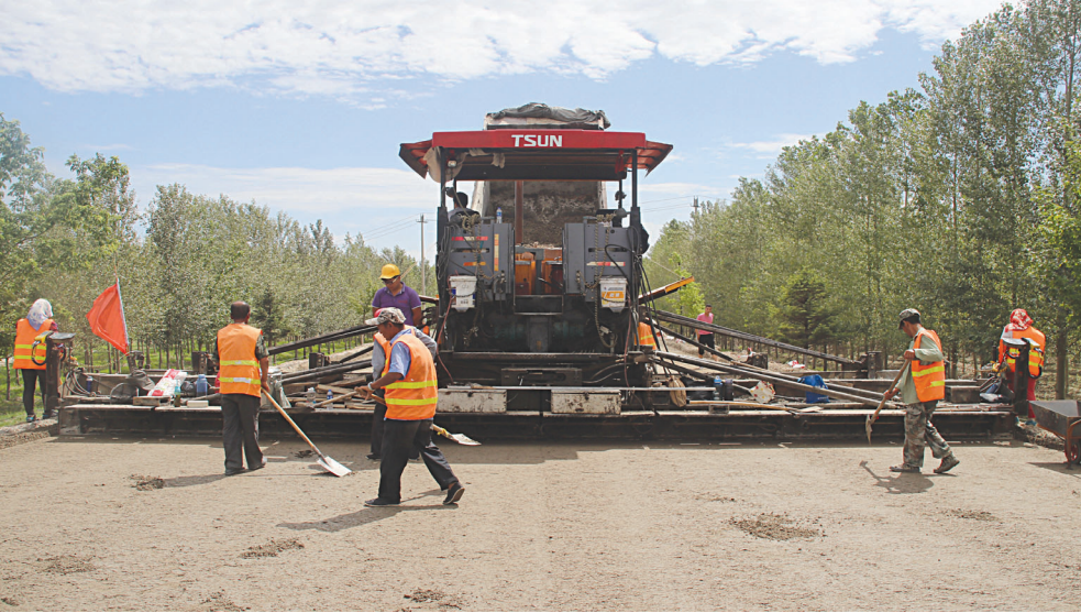
顶烈日、战高温,我市公路管理部门组织广大养路工人,加紧推进国道嫩双公路坦途至白城段养护工程,并努力打造区域性示范工程。该项目施工里程76.717公里,起点位于嫩双线吉黑省界,终点位于洮北区青山镇。截至目前,已完成40公里养护任务,9月15日前将全部完工。图为工程施工现场。 本报记者刘冠男摄
