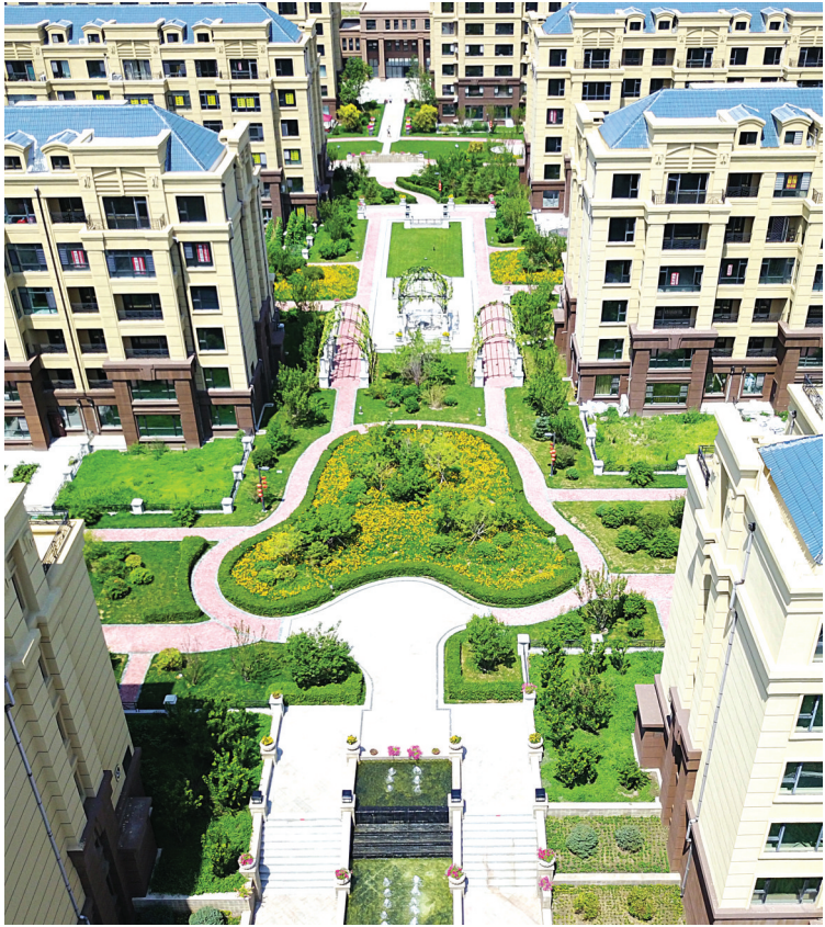
花园小区——“海绵城市”样板
