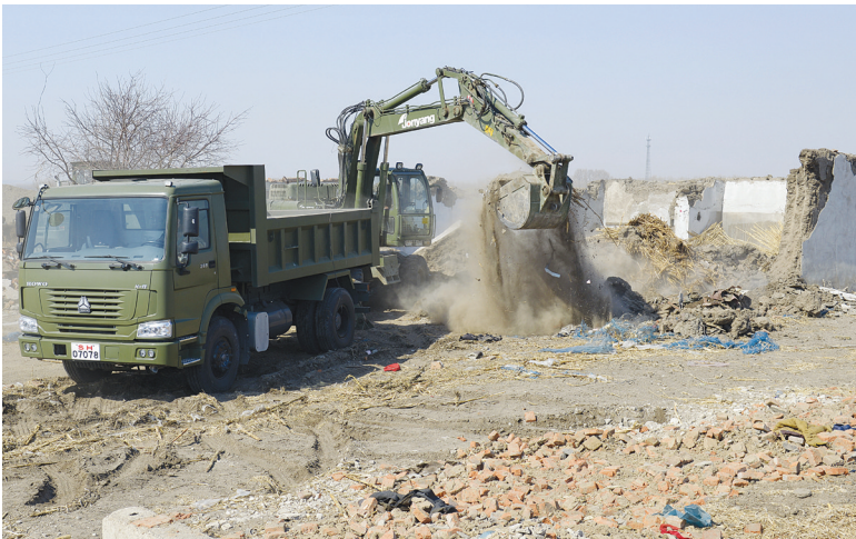
军民共建美好家园，洮北区平安镇联合驻平台63850部队出动工程机械，帮助中兴村村民拆除废弃房屋，恢复耕地。
