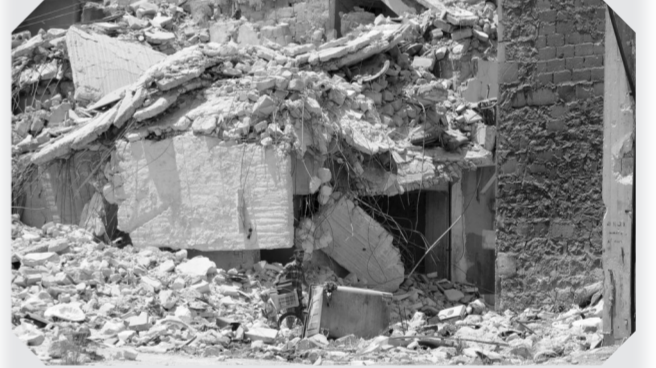
战后的阿勒颇,大量楼宇坍塌,瓦砾堆积。这座叙利亚曾经的第一大城市和经济中心,如今满目疮痍,如“鬼城”一般。2012年夏,阿勒颇战火爆发。历经4年多战火,2016年12月该市全面解放。那些曾经逃离家园的居民开始纷纷返回家园,试图开始新的生活,即使原来的“家”已变成了废墟中的危楼。65岁的穆罕默德·迪卜今年3月返回家中,靠开小卖部维持生计。虽然家中境况恶劣,但老人说:“我要留下来,这里承载着我家全部生命和奋斗成果。除了家,我还能去哪儿?”因为7月28日,在叙利亚北部城市阿勒颇,当地人在废墟中寻找可用物品。
