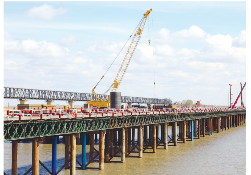
建设中的嫩江公路大桥
