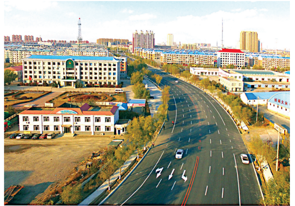
改造后的城市道路
