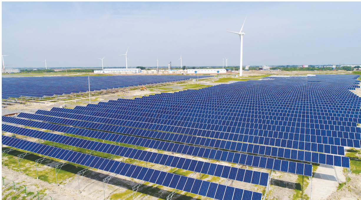
光伏产业引领绿色新能源蓬勃发展。目前，镇赉县有100兆瓦太阳能并网发电。
