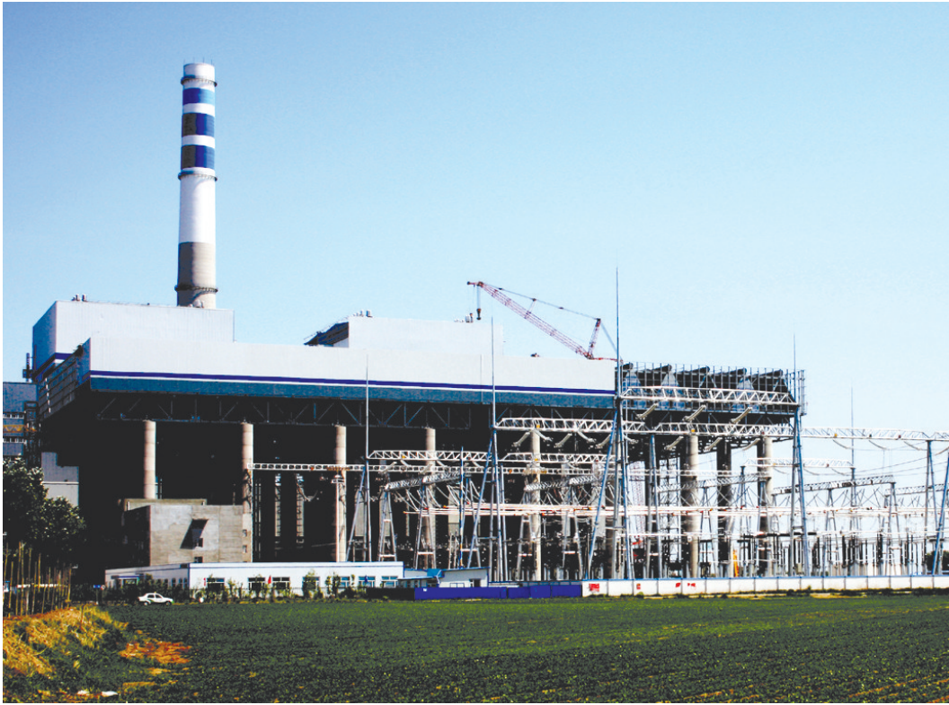
白城发电公司经过持续技术改造，生产工艺和产能已达到国内同行业领先水平。
