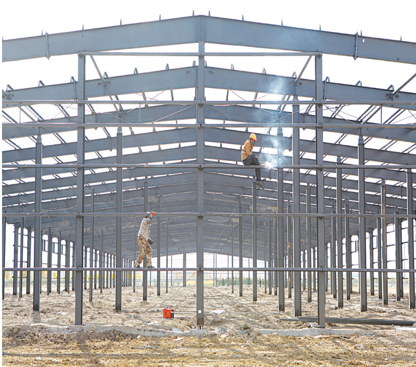
镇赉澎派食用植物油综合生产加工一体化项目
