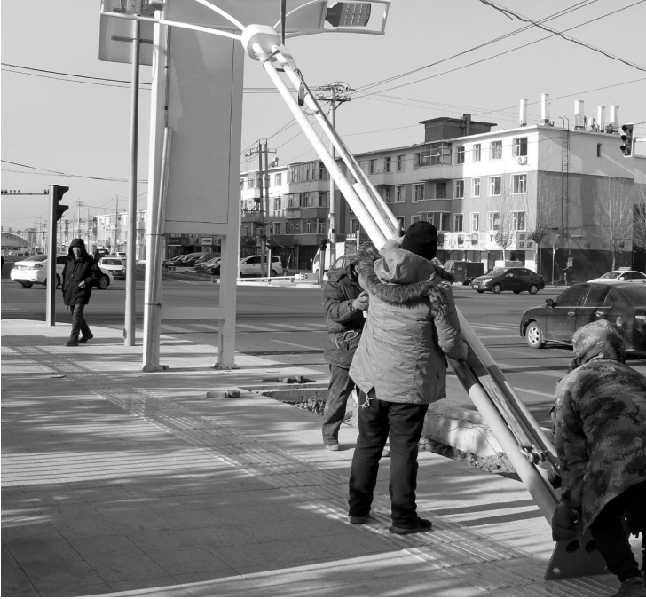
工人师傅在市区文化西路安装新路灯。今年，我市计划在新建的16条街路两侧安装1110基杆路灯，计划更换20条街路主、副杆光源1539个。截至目前，已完成12条街路782基杆的路灯安装工作，并投入使用，完成比例为71%；更换光源工作已全部完成。 本报记者马彬摄
