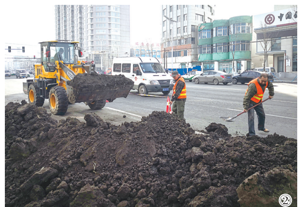
图①园林工人挖土做坑,为给树木春灌做准备。
