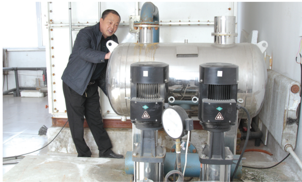
洮北区平安镇中兴村饮水安全工程于2014年10月建成,受益人口达1040人,实现了自来水入户,上下水便利,保障了村民卫生健康,提升了村民幸福指数。该工程促进了农村供水规范化建设,为新农村建设起到了示范作用。图为4月15日饮水安全工程技术人员正在检测饮水设备。 本报记者马彬摄
