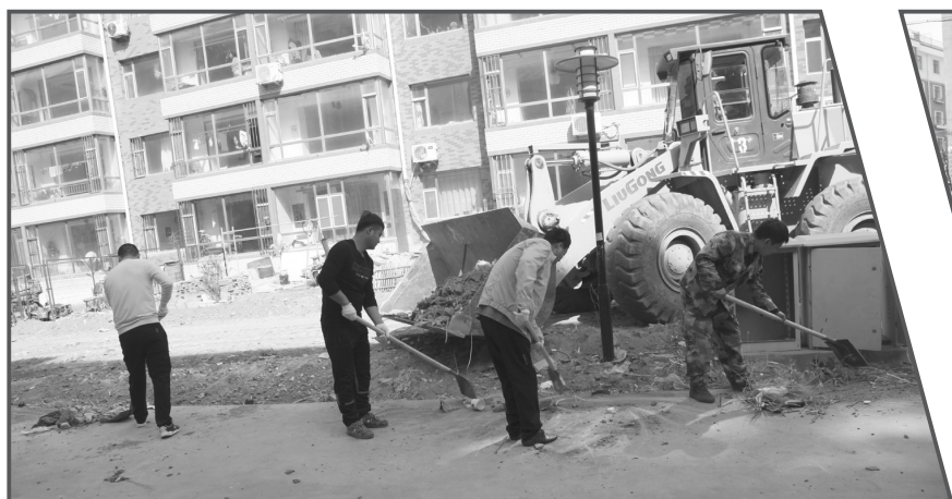
图为清理建筑垃圾。
