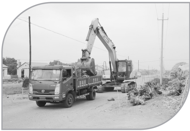
图为莫莫格蒙古族乡环境整治施工现场。潘晟昱摄
