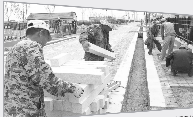
镇赉县粮商局包保干部在莫英格蒙古族乡巴喜召村修建排水沟。潘晟昱摄
