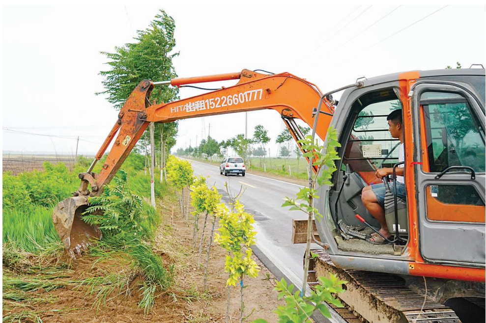
6月21日，公路养护工人在操作机械设备修补黄骅市常郭镇境内一条乡村公路的路肩。 近年来，河北省黄骅市政府积极推进农村公路建设和维护，构筑出村村通公路的城乡全覆盖公路网，并购买了100多辆新能源公交车投放到城乡之间运行，让广大群众实现“出门走油路，抬脚上公交”，享受“四好农村路”带来的便利和实惠。 新华社记者杨世尧摄
