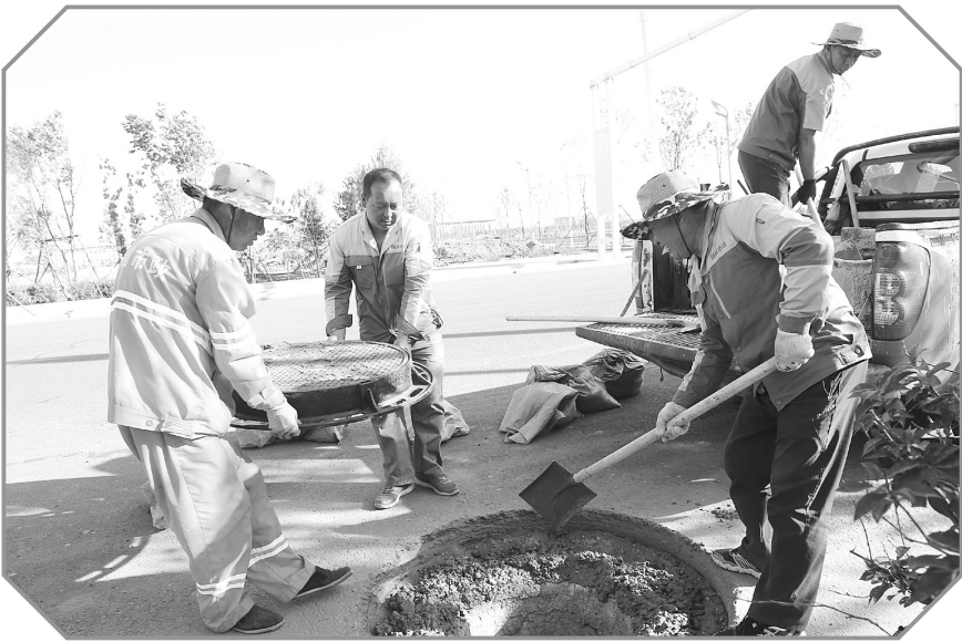
为避免破损井盖给行人和车辆带来不便,造成安全事故,白城市锦园市政工程建设有限公司维护养护人员在破损井盖旁放置醒目标志,并及时对破损井盖进行更换,使道路面貌有了改善。图为养护人员在更换井盖。王昕 本报记者张殿文摄
